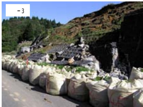
土嚢に草が生えていることから、台風23号によって発生した地滑りが、今回の地震によって再活動したようである。
