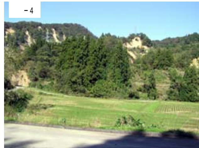
野辺川の北側に続く主滑落崖も同様である。これらの主滑落崖基部には新たなクラックが発生していないため、大規模地すべりの危険度が高まったとは認め難い。
