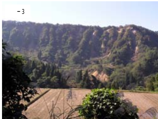
大規模地すべりの西縁主滑落崖(野辺川の南側)には、いたるところで小規模な崩落が発生している。
