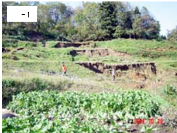
住民の話では、棚田は台風23号により崩落したらしい。
