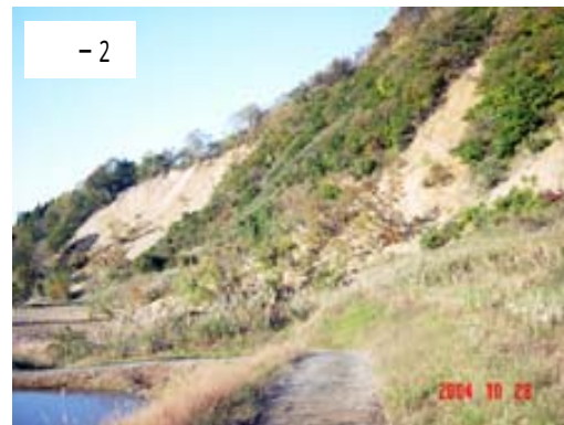
-2 主滑落崖からの崩落はあるものの、主滑落崖の基部には新たなクラックは発生していないので、将来の大規模地すべり発生危険度が高まったとは認め難い。
