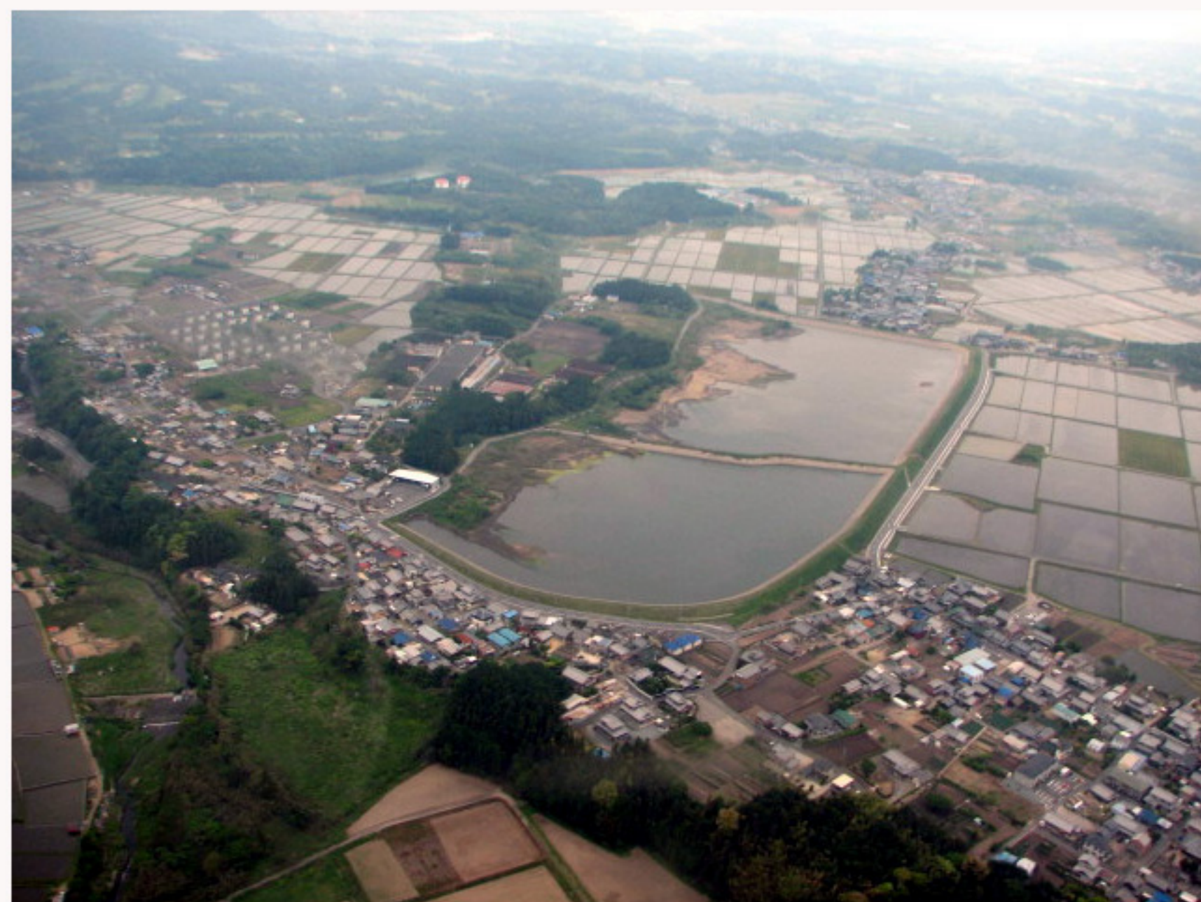
図2. 棕本断層（写真奥から手前方向に伸びる）. 右は横山池， 三重県防災へりより，本田 裕撮影，2007年5月16日
