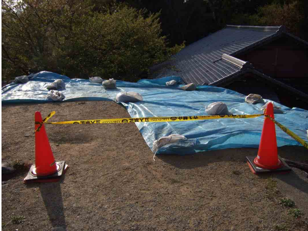
旧亀山城多門櫓 上段部の亀裂 ブルーシートによる養生
