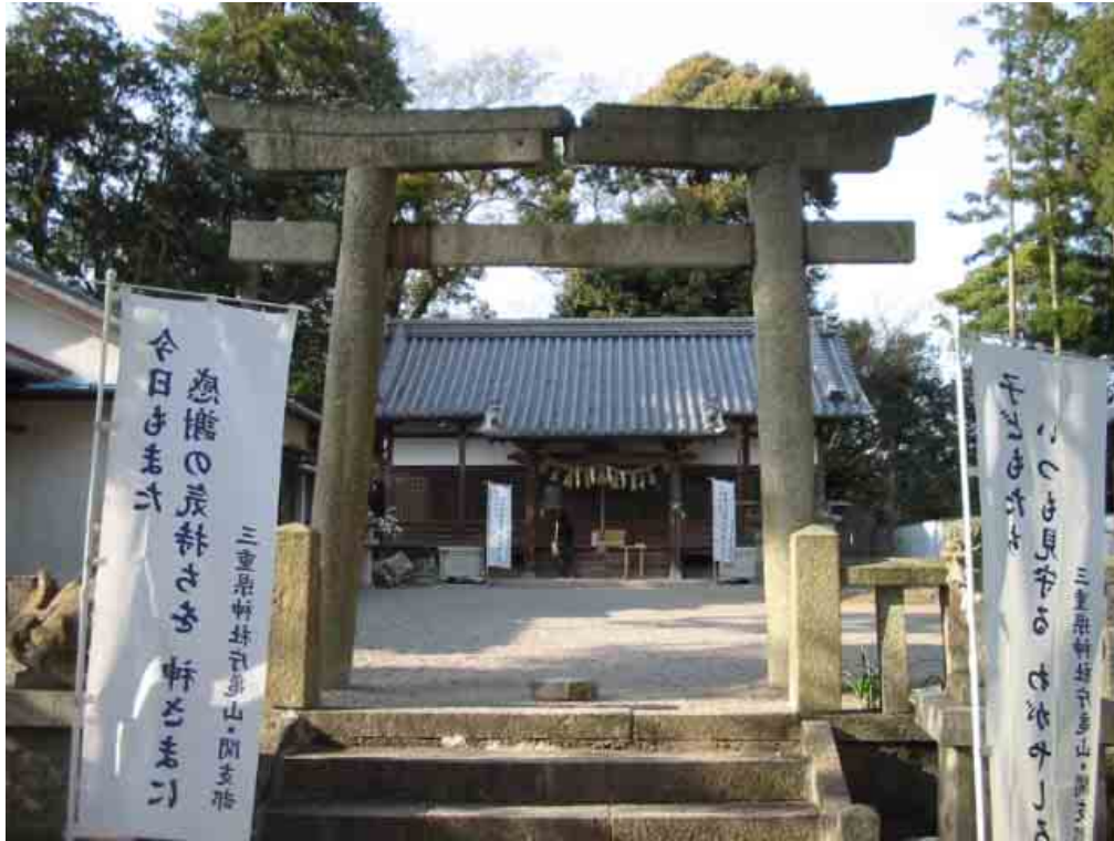
関神社（関町木崎675）石造物（鳥居）の損壊
