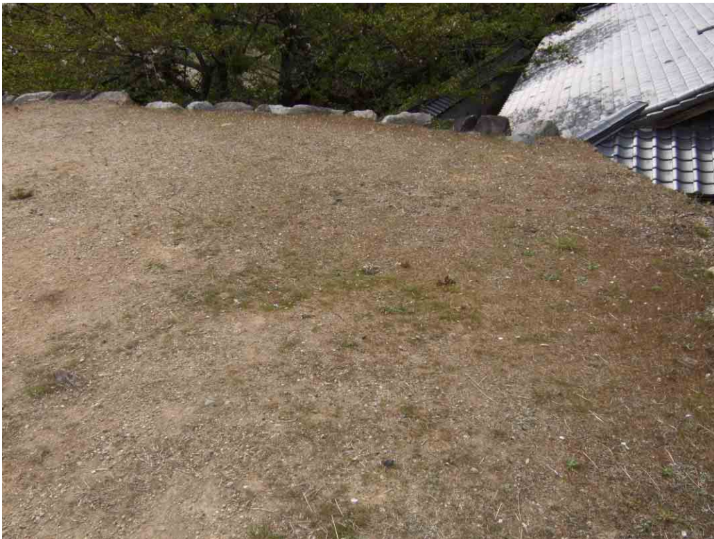
旧亀山城多門櫓 上段部の亀裂
