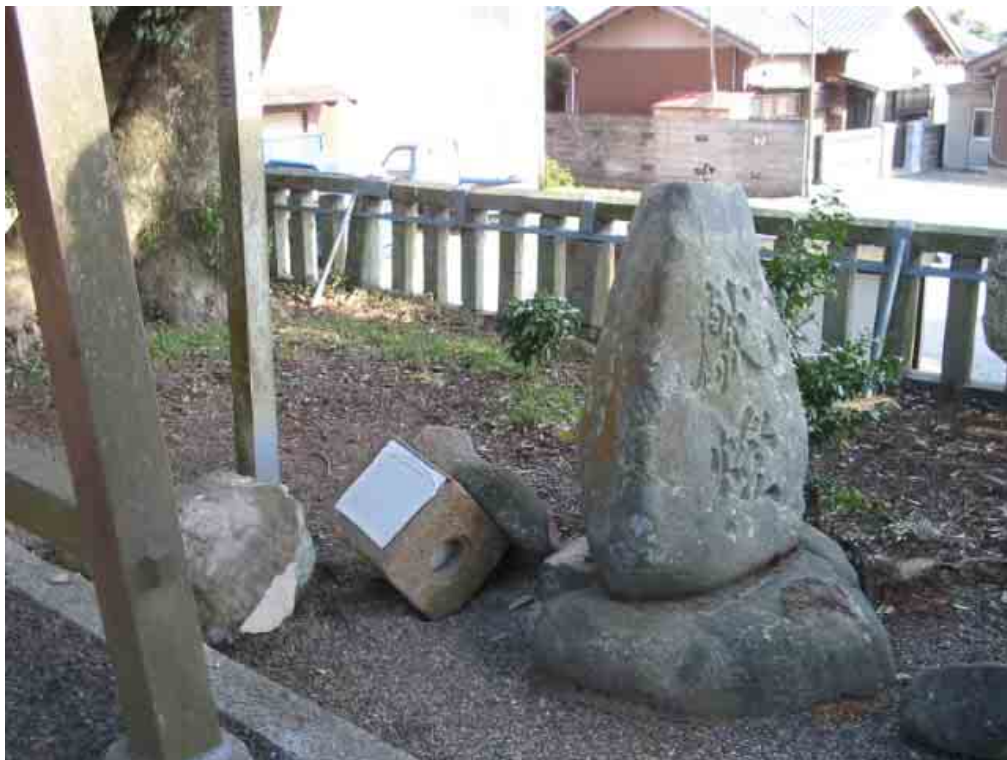
関神社（関町木崎675）石造物（灯籠）の損壊
