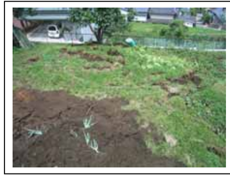
写真2 畑ののり面が崩壊した表層地滑り
