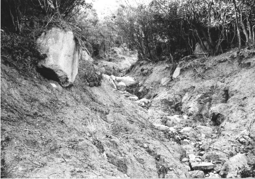
写真2 崩壊地の中腹部：谷が幅約10m削られ、溪床洗掘による溝も形成されている。
