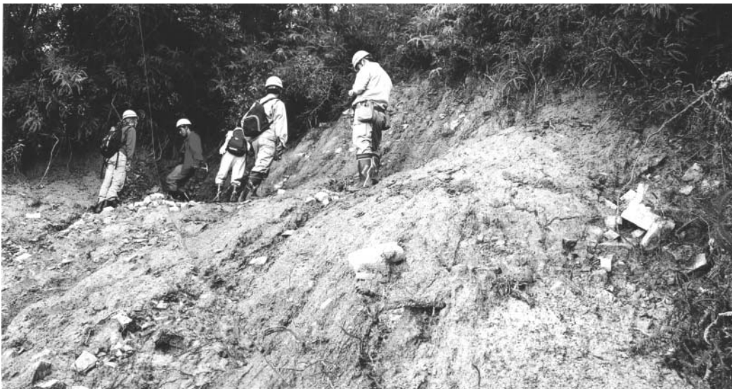
写真3 発生源の崩壊地（源頭部）：表層はまさ土でルーズである。ところどころに基盤岩の花崗岩の露出が認められる。
